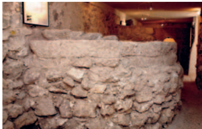
Resti di abside laterale di XII-XIII secolo.
